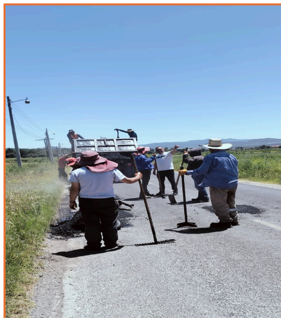
Trabajos de bacheo en el acceso a Rancho Luna, Universidad Politécnica de Pachuca.
