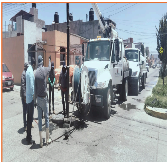
Supervisión de trabajos preventivos a la red de drenaje sanitario en fraccionamientos
