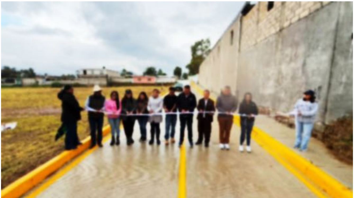
En Santa Gertrudis se colocaron huellas de concreto hidráulico.
